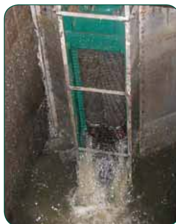
Muffin Monster в насосной станции
