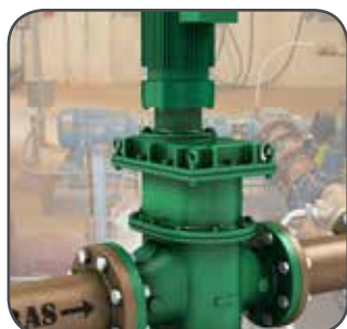
Серія 10K, фланцева установка Ін-лайн «в лінію»
